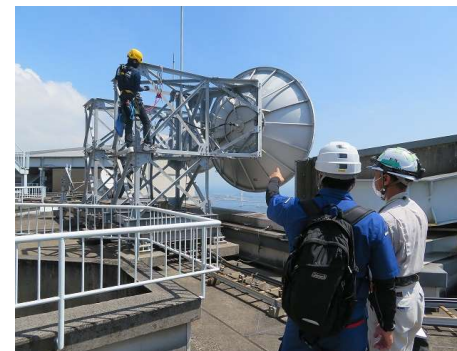
定期的に維持管理のための作業を実施
