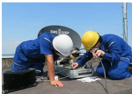
災害等に備えた衛星可搬設備の立ち上げ訓練
